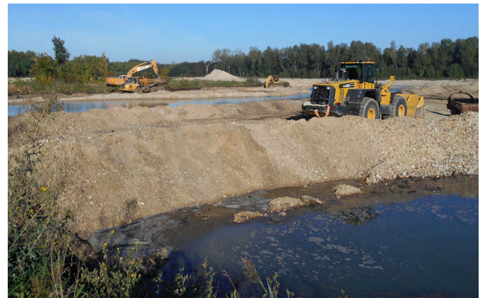
Réaménagements d'une partie de la carrière
